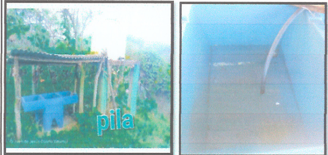
Foto 2: Falta de agua.
